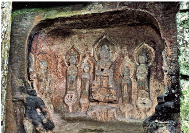
图18 烂泥沟第4龕（西南—东北）
